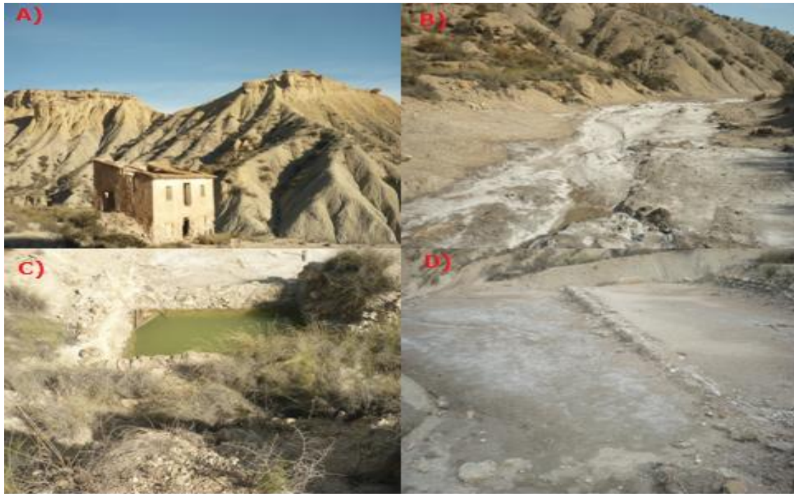
Figura 1. Salinas del Curro (Ricote). A) Vivienda-almacén, B) Afloramiento salino en rambla, C) Balsa almacenaje salmuera, D) Vista parcial eras de cristalización Fuente: Sánchez-Sánchez, M.A. (2015).
